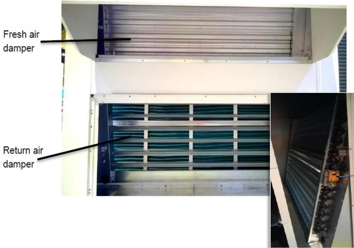
L'attuatore controlla la % di apertura della serranda, in base a uno di questi principi:
